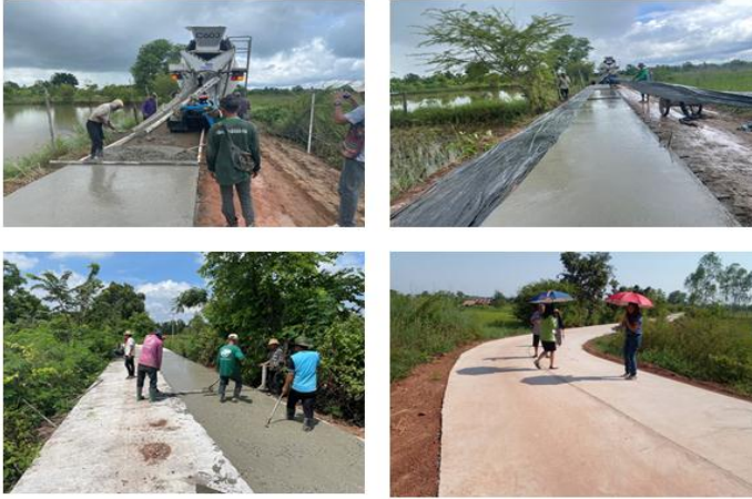
ก่อสร้างถนนคอนกรีตเสริมเหล็ก บ้านพันนา หมู่ที่ ๑ (สายพันนา - โนนสวนน้ำ) งบประมาณ ๑,๑๘๐,๐๐๐ บาท
