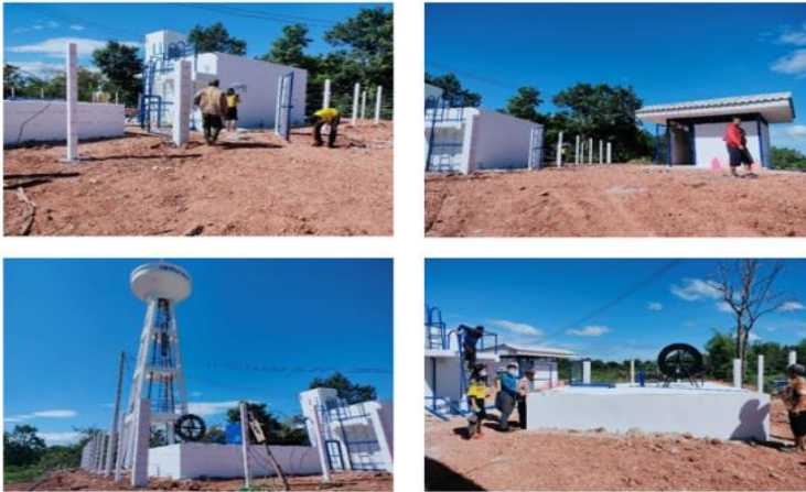
ก่อสร้างระบบประปาหมู่บ้านแบบผิวดินขนาดกลาง บ้านหนองปลาเจ็ง หมู่ที่ ๘ งบประมาณ ๒,๐๓๐,๒๐๐ บาท
