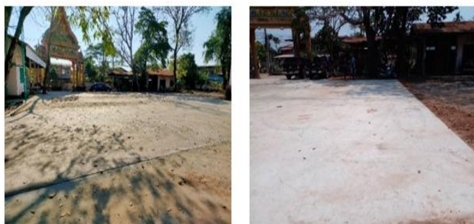
ก่อสร้างลานกีฬาเอนกประสงค์ บ้านพันนาใต้ หมู่ที่ ๑๐ งบประมาณ ๒๑๒,๐๐๐ บาท
