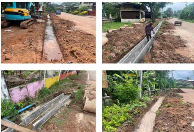
ก่อสร้างรางระบายน้ำสำหรับบ้านพันนา หมู่ที่ ๑ (สายอาจข้าว - บ้านนางปรีชา สุวรรณเขต) งบประมาณ ๒๓๘,๕๐๐ บาท
