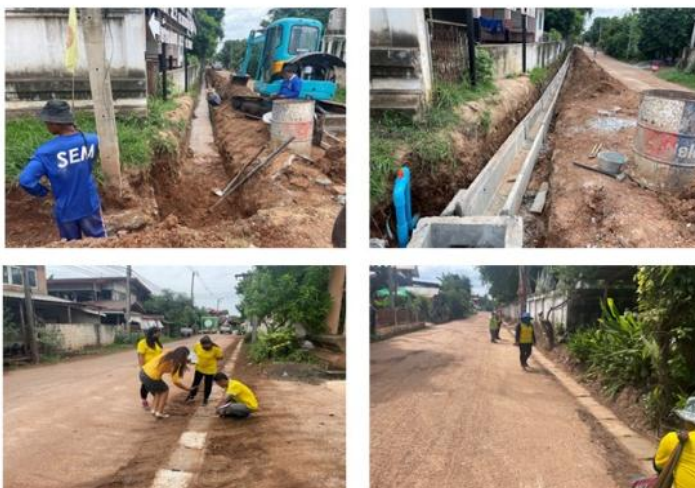
ก่อสร้างรางระบายน้ำสำหรับบ้านพันนาใต้ หมู่ที่ ๑๐ (สายวัดโนนธรรม-หน้าบ้านนางโสภา ไชยเพชร) งบประมาณ ๑๘๗,๖๐๐ บาท
