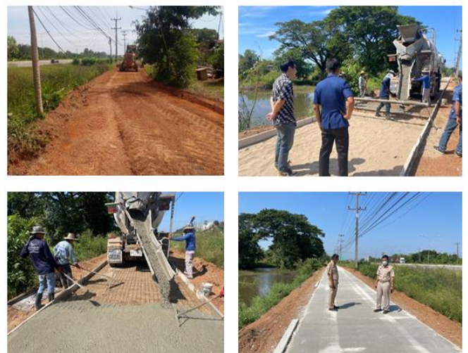
ก่อสร้างถนนคอนกรีตเสริมเหล็ก บ้านพันนา หมู่ที่ ๑ (สายบ้านนายสุกชัย แสนราช - ส.เจริญการไฟฟ้า) งบประมาณ ๑,๑๘๐,๐๐๐ บาท
