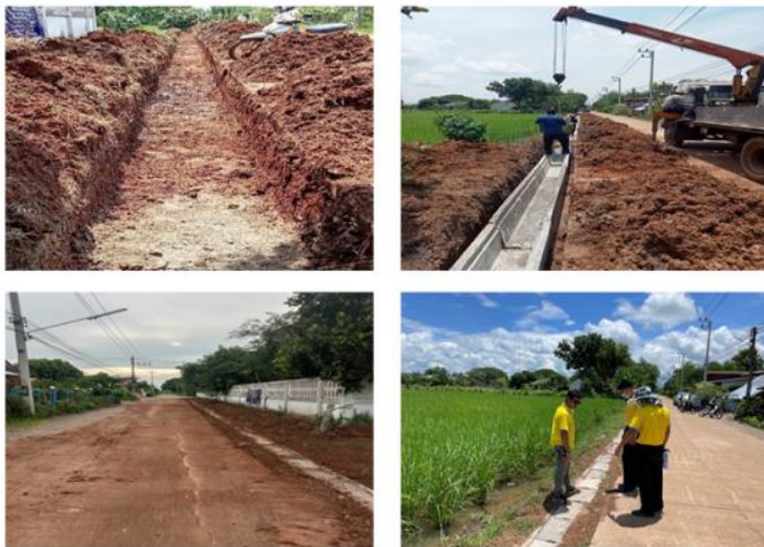
ก่อสร้างรางระบายน้ำสำหรับบ้านโพน หมู่ที่ ๒ (สายบ้านนายสงวน ไชยบุตร - บ้านนางแสงเดือน ประทาพันธ์) งบประมาณ ๑๖๐,๓๘๖.๗๒ บาท
