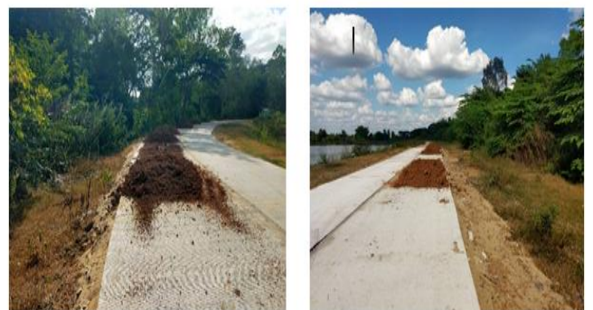
ก่อสร้างถนนคอนกรีตเสริมเหล็ก บ้านพินนาใต้ หมู่ที่ ๑๐ งบประมาณ ๕๔๘,๐๐๐ บาท
