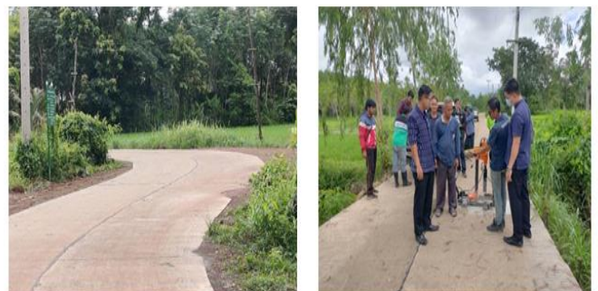
ก่อสร้างถนนคอนกรีตเสริมเหล็ก บ้านหนองไผ่ขาว หมู่ที่ ๙ - ตำบลวังพัฒนา งบประมาณ ๑,๘๖๘,๐๐๐ บาท
