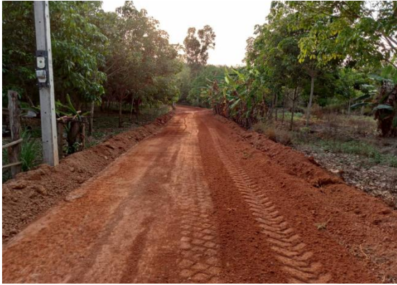
โครงการก่อสร้างถนน คสล. สายบ้านคำตานา หมู่ที่ ๖ - สร้างใจ
